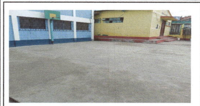
Foto1:Reparación de piso de torta de concreto.
